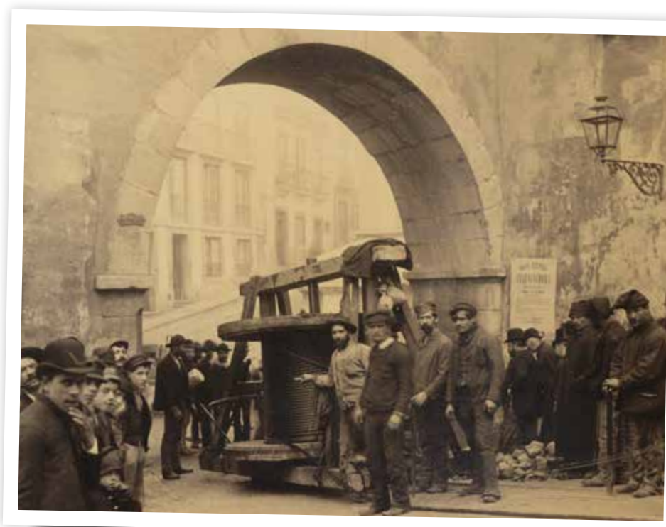
In Lissabon baute die ME die ersten Streckenabschnitte der Kabelstraßenbahn und dokumentierte die Arbeiten in einem Album. Hier: Verlegung des Stahlseils im Jahre 1892.
