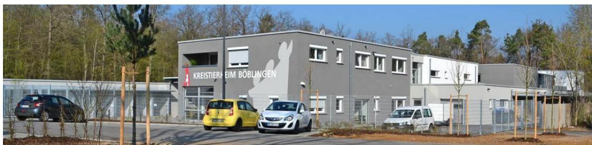
Die Obergeschosse sollen wie Schallschutzbarrieren die Nachbarschaft vor Lärm aus dem Kreistierheim schützen.
