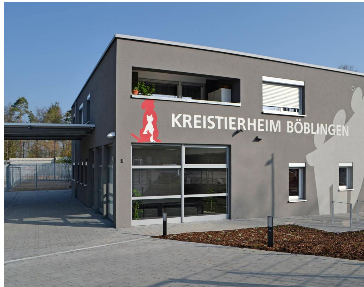
Kubische Flachdachgebäude sind zum Komplex des neuen Kreistierheims Böblingen zusammengesetzt. FOTOS: LANDRATSAMT BÖBLINGEN
