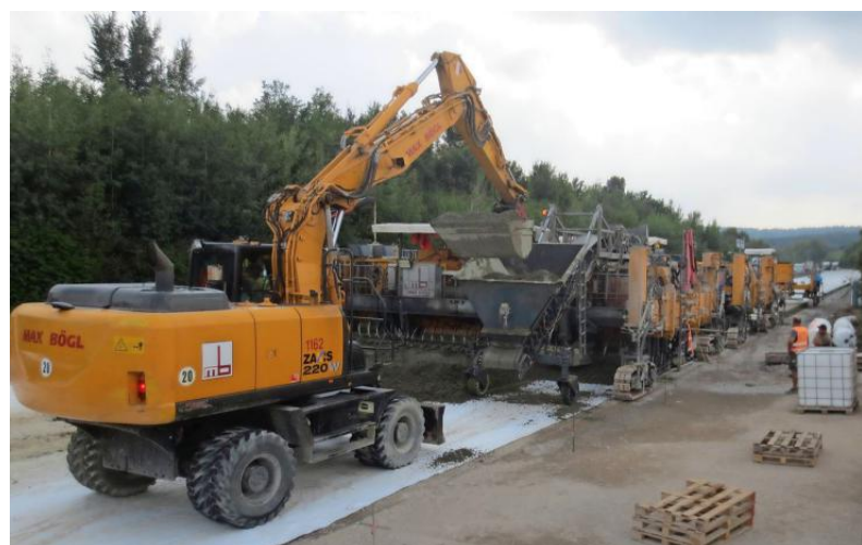
Asphaltarbeiten auf der A 81: Die Mischung aus dem Bindemittel Bitumen und Gesteinskörnungen wird für die Befestigung der Fahrbahn aufgebracht.
