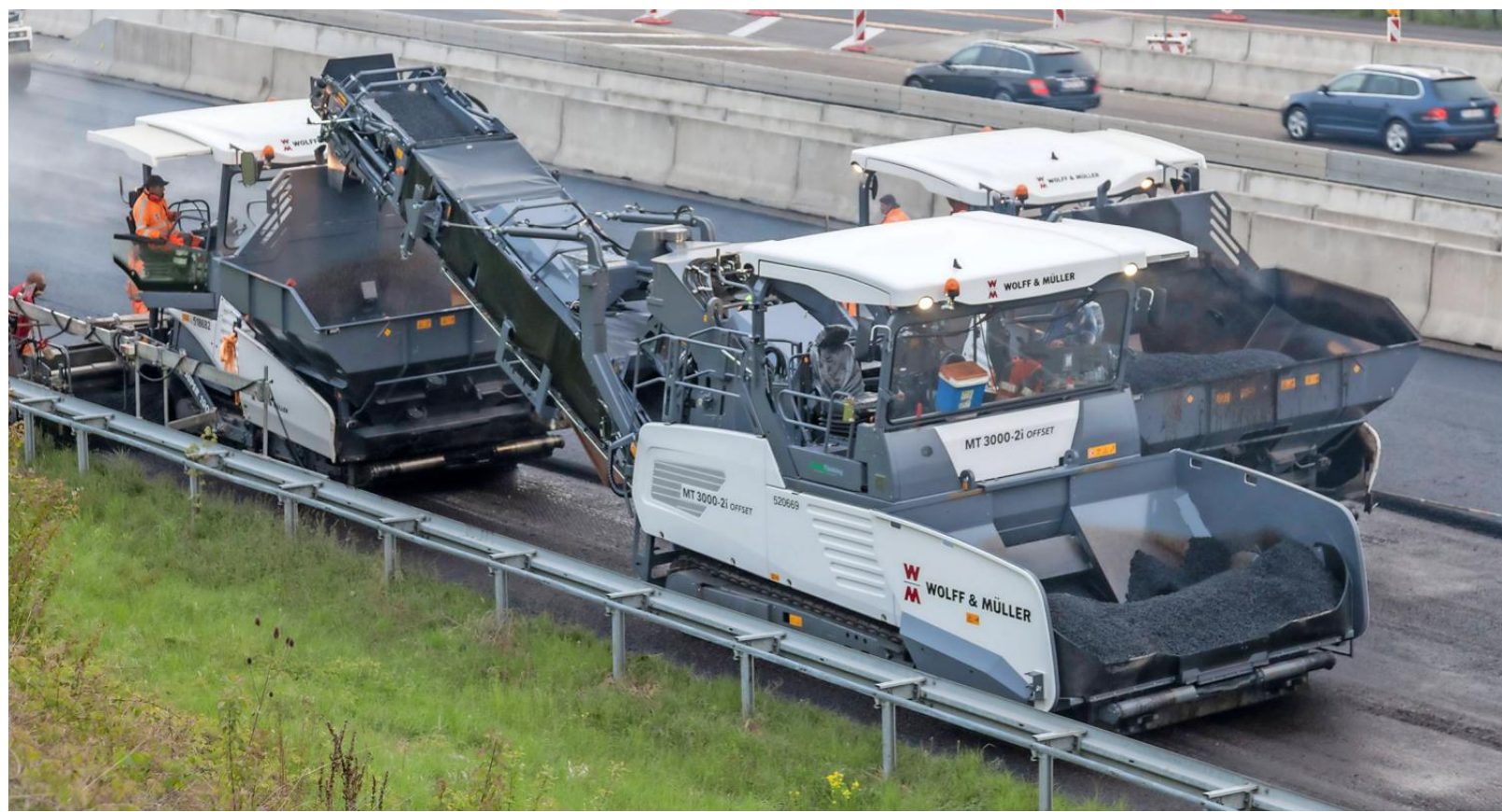
Mit der neuen Fahrbahndecke sollen die Autofahrer unter anderem auch vor Aquaplaning geschützt werden. FOTOS: REGIERUNGSPRÄSIDIUM STUTTGART
