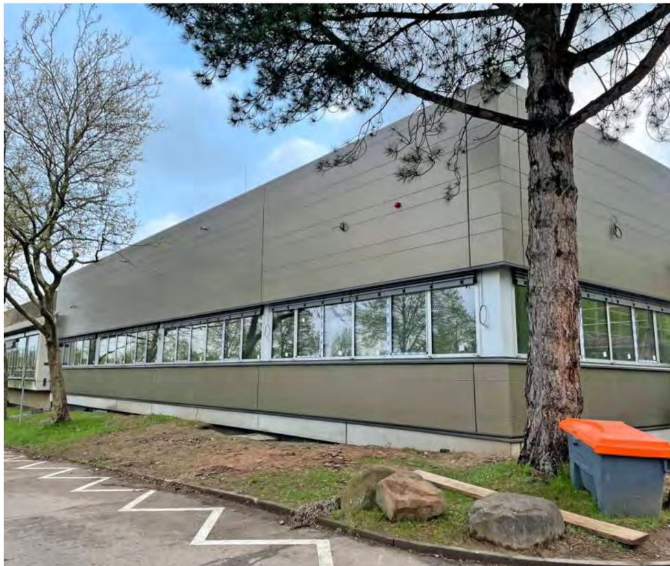
Die Instandsetzung des Werkstattgebäudes der Hermann-Wieland-Schule ist der aufwendigste Teil der Sanierung. Die Fassade des ehemaligen Fabrikgebäudes, das zur Schmuckproduktion errichtet wurde, wurde komplett durch ein hochgedämmtes System aus bronzefarbenen Stahlpaneelen ersetzt (oben). Im Hauptgebäude der Schule wurde ein Aufzug eingebaut, um alle Etagen barrierefrei zugänglich zu machen (rechts).
