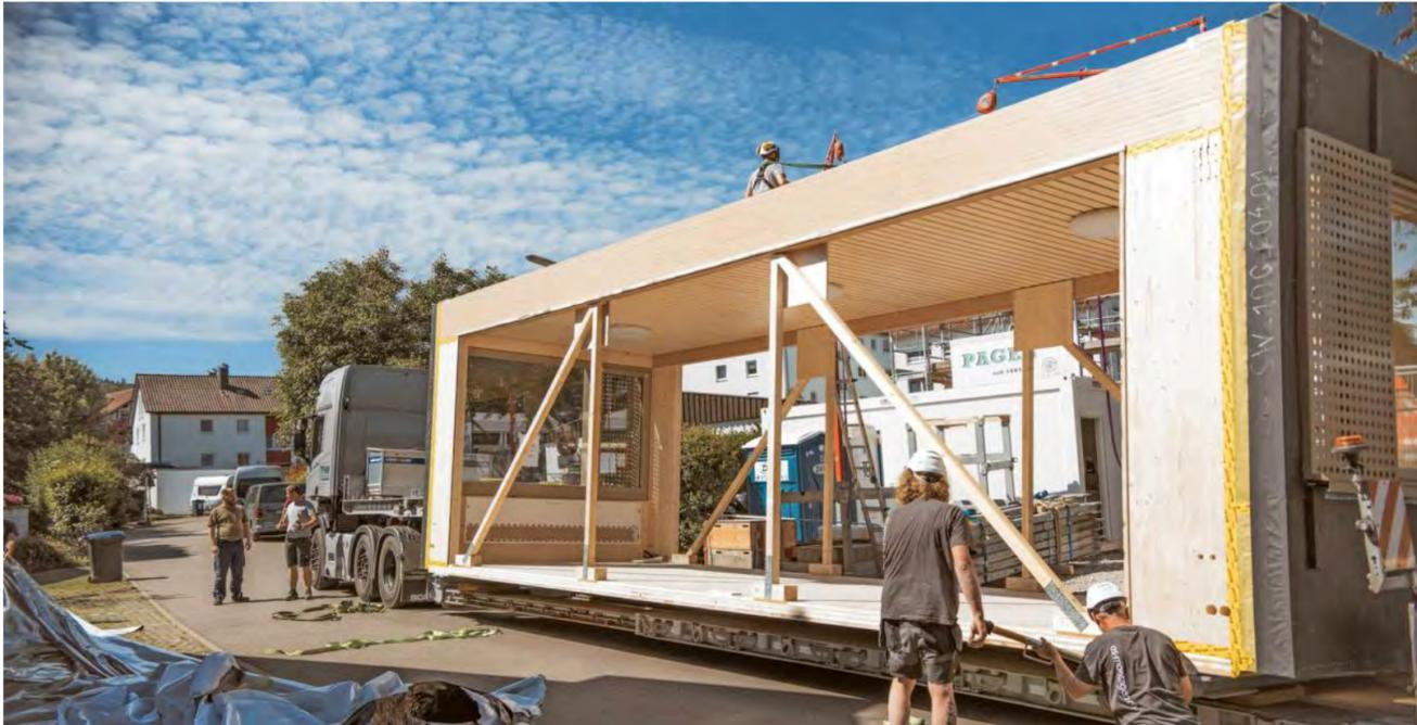
Die Holzmodule für den Erweiterungsbau wurden in der Fabrik vorproduziert und per Tieflader nach Schorndorf transportiert. FOTO: BLUMER-LEHMANN
