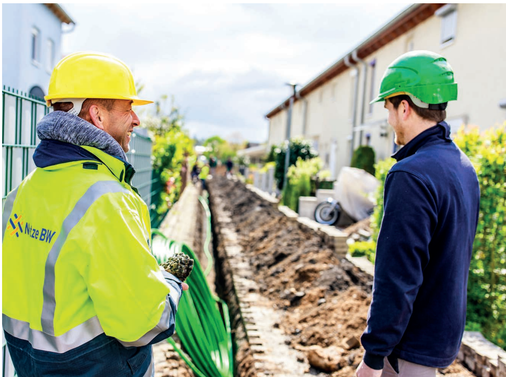
Mitarbeiter der Netze BW bei der Verlegung von Erdkabeln. FOTO: NETZE BW / PAUL GÄRTNER
